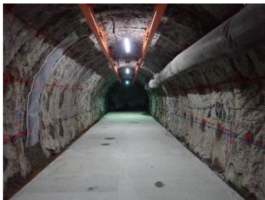
試験坑道6の掘削完了時の様子
