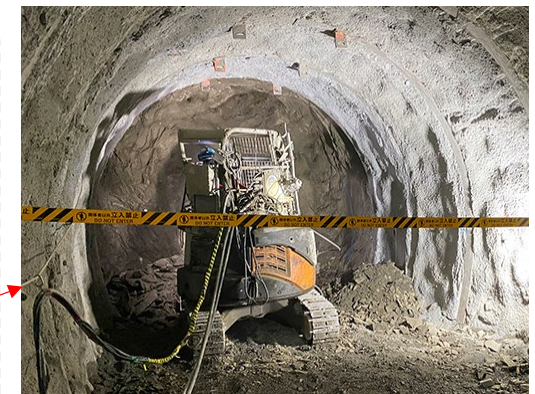
試験坑道7の掘削の様子
